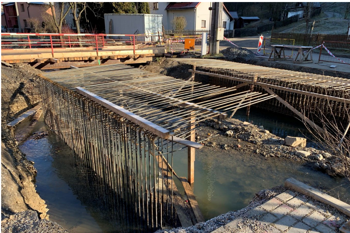
Stavba mostu u hasičské zbrojnice, 27. 12. 2020
