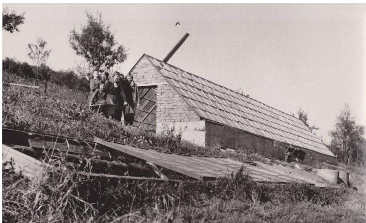
Stavba skleníku, rok 1966
